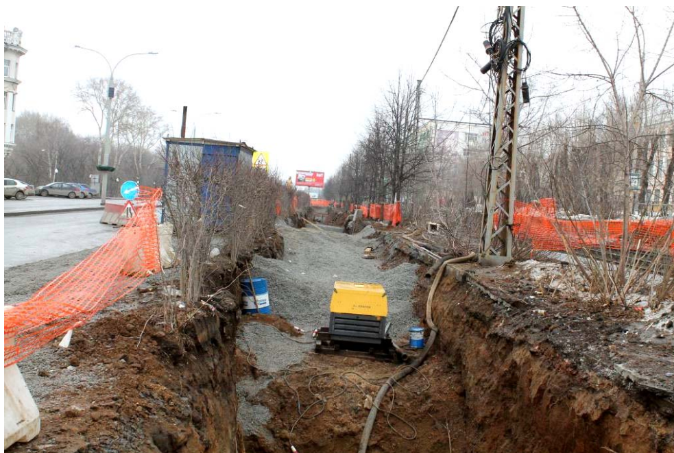
Рисунок Ж.1 – Реконструкция коммуникаций и дорожного покрытия на Верх-Исетском бульваре (осень 2015 г.– зима 2016 г.). Направление съемки – на юго-восток, в сторону ул. Московской (фото Кайзер Н.В.), 2016 г.
