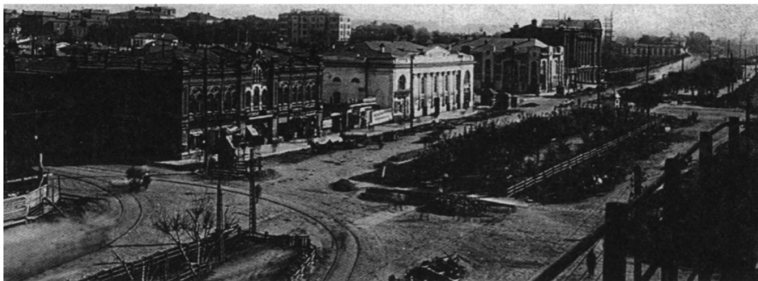
Рисунок 4.25. Бульвар на проспекте Ленина. Перекресток ул. Ленина – ул. Толмачева. Фото 1930-е гг. (Елагин, 2011). Видны отрезки бульвара – вдали фрагмент бульвара от ул. К. Либкнехта до ул. Тургенева
