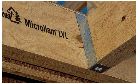
Рис. 6. Соединение балок из LVL-бруса
