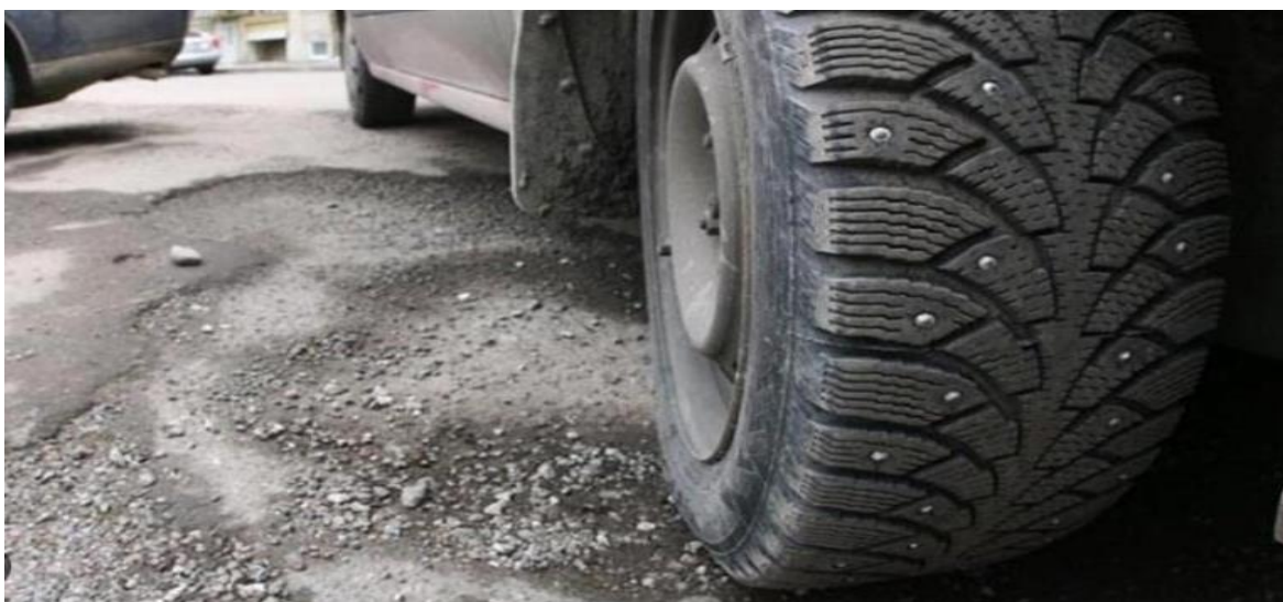
Рис. 1. Стирание верхнего слоя от шипованных шин
