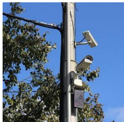
Способы установки видеодетектора
