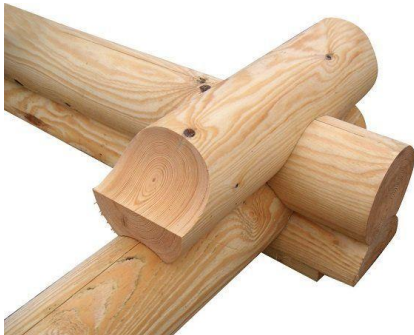
Рис. 5. Соединение оцилиндрованных бревен
