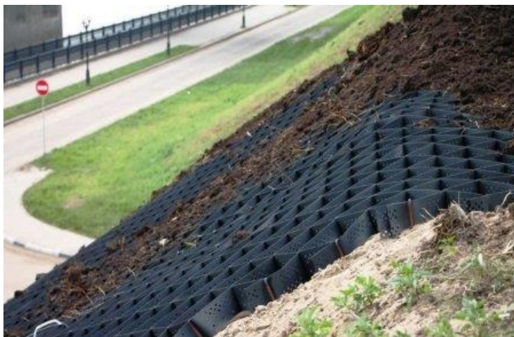
Рис. 1. Применение георешетки при возведении откосов насыпи
