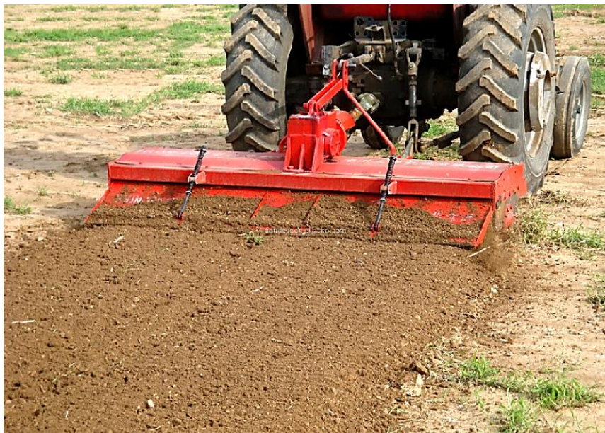
Рис. 4. Смешение грунта и портландцемента грунтовой фрезой
