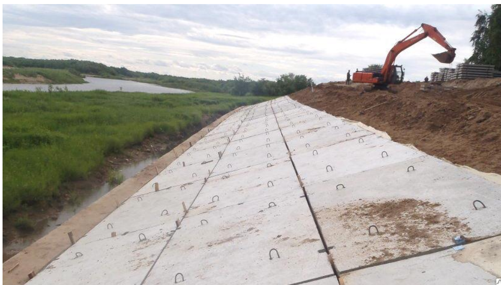
Рис. 5. Установка плит
