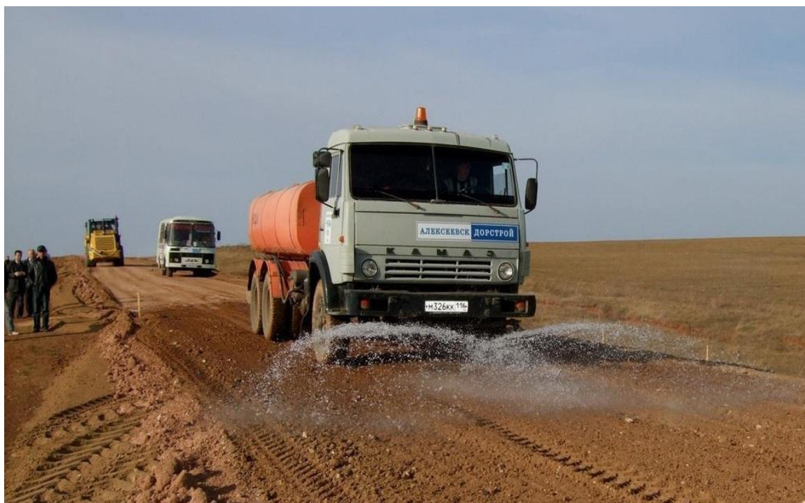
Рис. 3. Поливка измельченного грунта, смешанного с порошкообразным вяжущим
