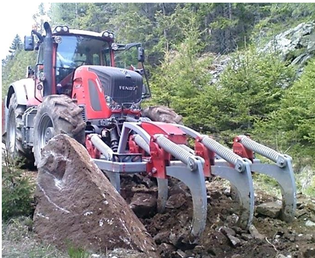
Рис. 1. Снятие верхнего непригодного для дальнейшего укрепления слоя
