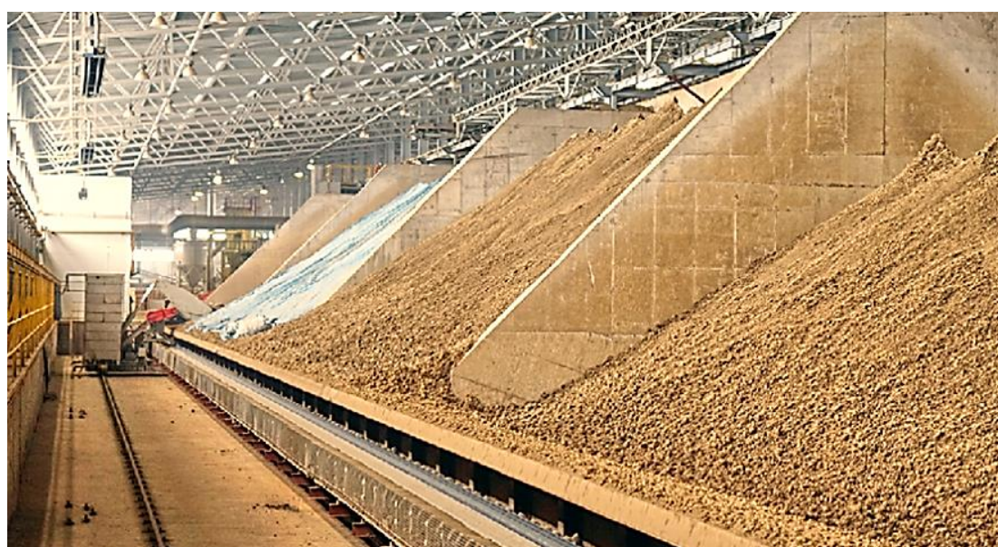
Рис. 2. Склад для временного хранения грунта
