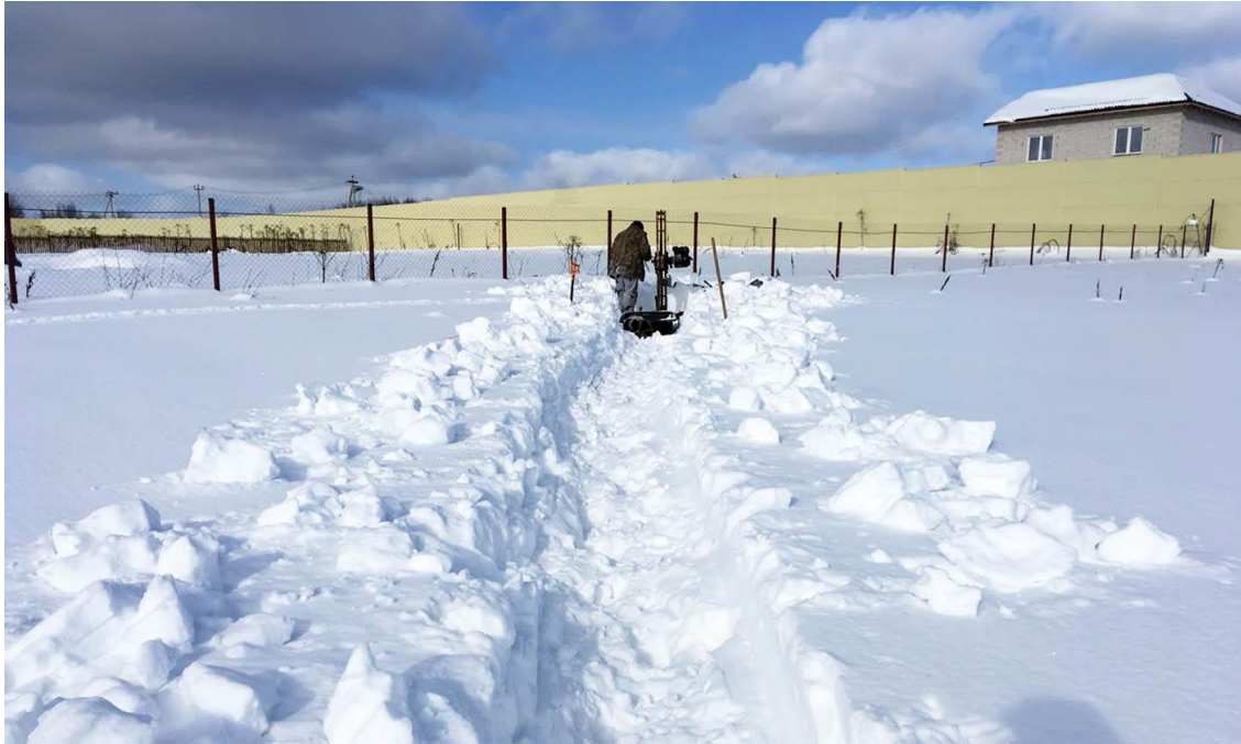
Рис. 2. Пример проведения инженерно-геодезических изысканий в зимний период
