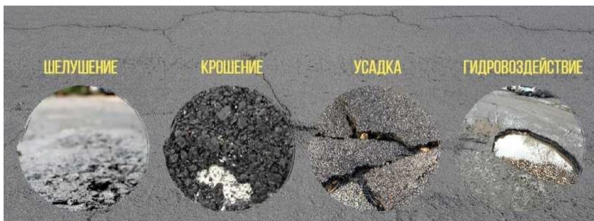
Рис. 1. Дефекты асфальтобетона, образовавшиеся из-за неправильно подобранного вяжущего
