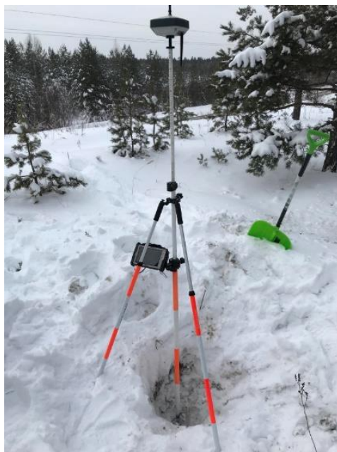
Рис. 1. Пример установки базовой GPS станции при проведении инженерно-геодезических изысканий в зимний период
