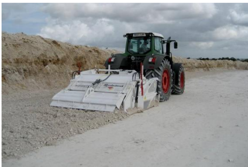
Рис. 1. Прицепной грунтовый смеситель для укрепления грунтов
