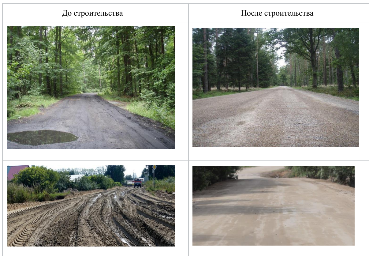
Рис. 4. Результат строительства лесовозных автомобильных дорог по технологии укрепления грунтов со стабилизирующими добавками
