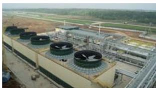
В состав водоблока входят шесть секций блочно-модульных градирен пят
