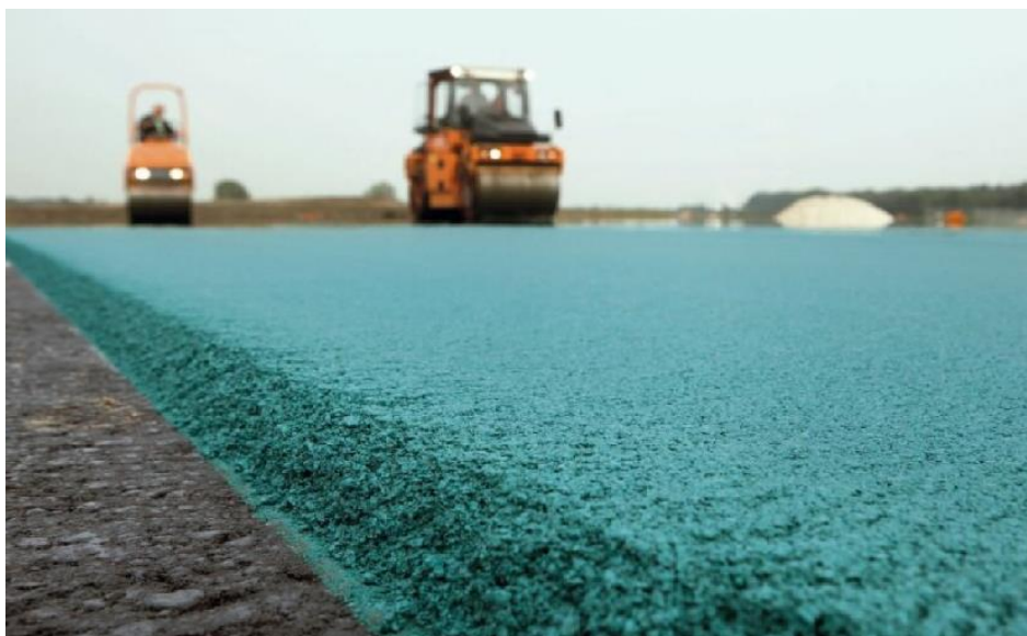
Рис. 6. Специальное покрытие, отражающее солнечные лучи
