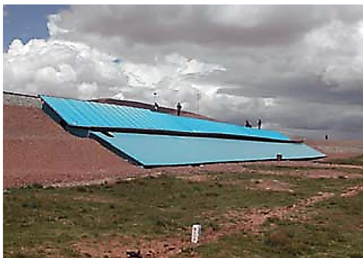
Рис. 2. Солнцезащитные навесы на откосах насыпи
