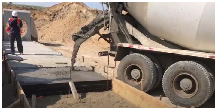
Рис. 3. Заливка опалубки
