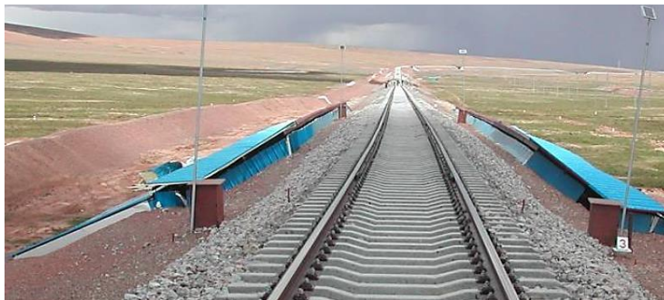
Рис. 1. Солнцезащитные охлаждающие экраны
