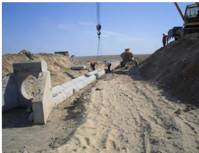
Рис. 2. Установка лекальных блоков
