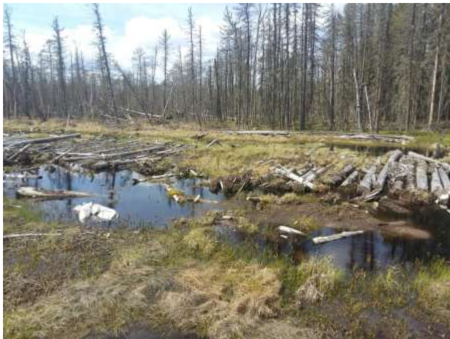
Рис. 6.12 - Подтопление, вызванное лежневой дорогой без организованного водотока
