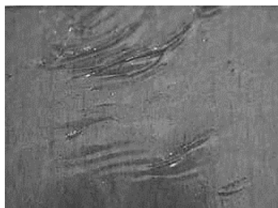
Рис. 4. Сморщивание лакокрасочного покрытия
