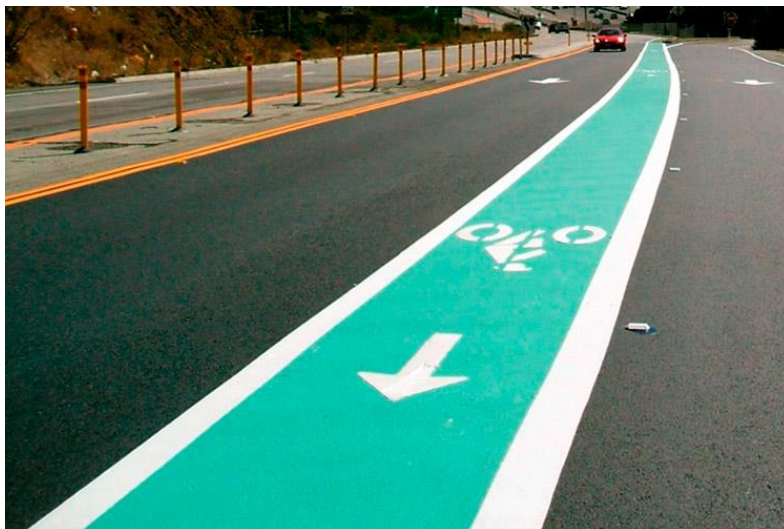
Пример устройства покрытия велодорожки из цветного асфальтобетона
