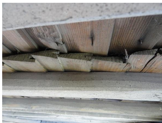
Рис. 2. Установка гонтин в настильном ряду
