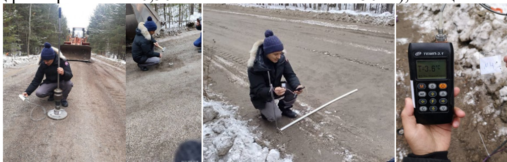
а) динамическим плотномером ZFG-3000-10 GPS; б) методом режущего кольца; в) установка термопары ХК (L); г) измерение температуры грунтовермикулитового слоя Темпер-3.11
