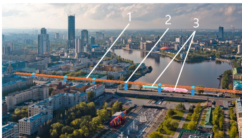
Рис. 5. Надземная транспортная система Екатеринбурга: 1 – рельсовая линия; 2 – опора; 3 – вагоны попутного и встречного движения
