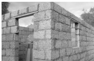
Рис. 4. Строительство жилого дома из арболита
