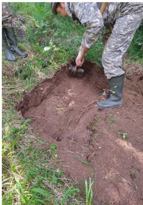
Рисунок 5.3 – Подготовка площадки для установки металлических трубок
