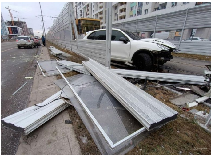
Рис. 2. Шумозащитный экран после дорожно-транспортного происшествия
