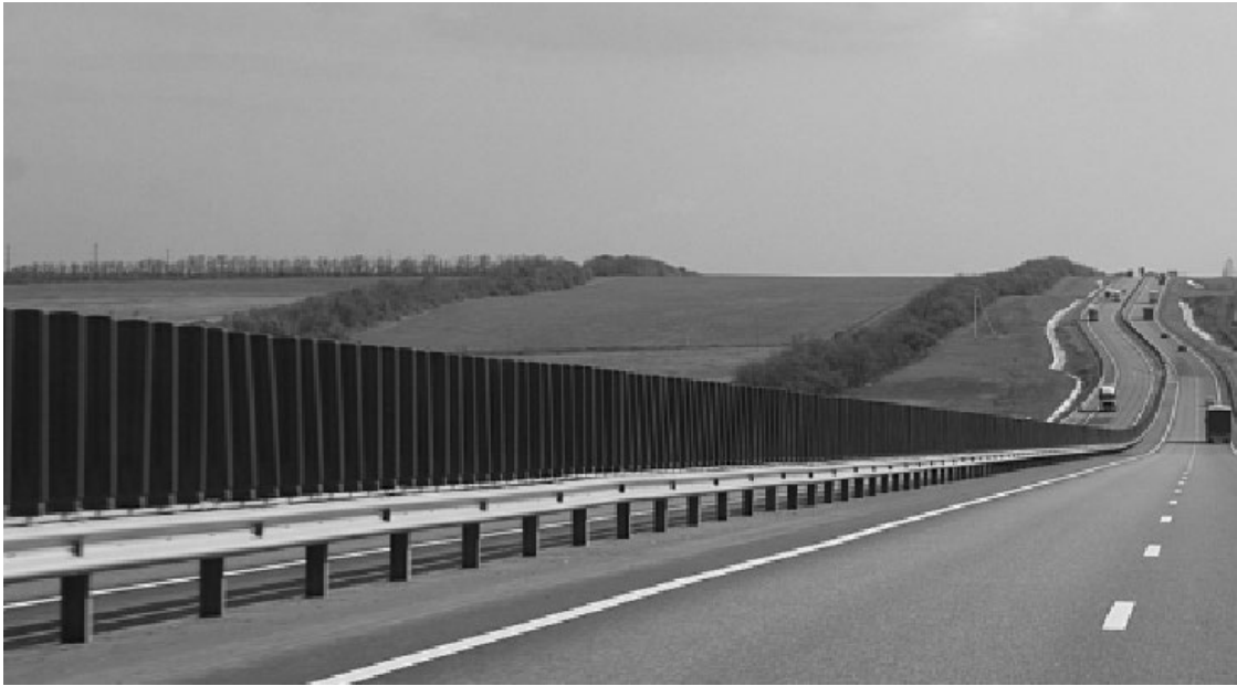
Рис. 2. Противоослепляющие экраны из композитного материала с использованием резиновой крошки
