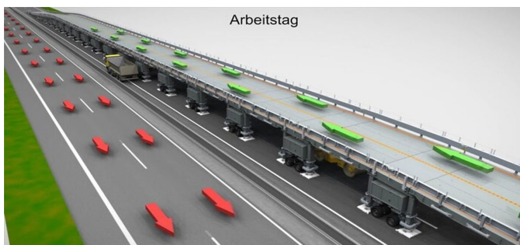
Рис. 3. Модульный передвижной мост для проведения ремонтных работ
