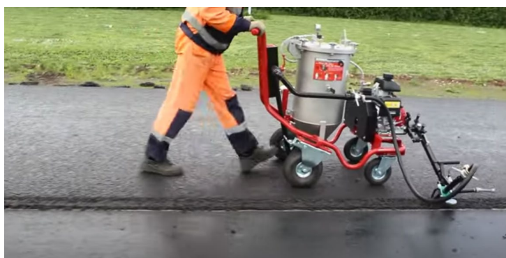
Рис. 2. Нанесение жидкой ленты
