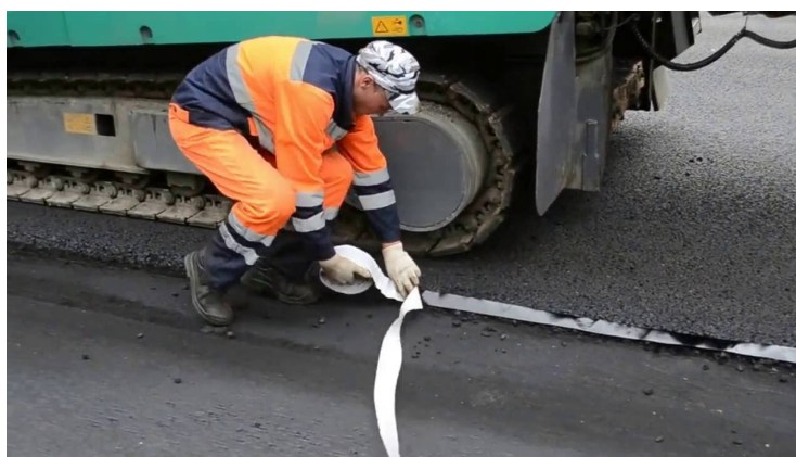
Рис. 1. Нанесение битумно-полимерной ленты
