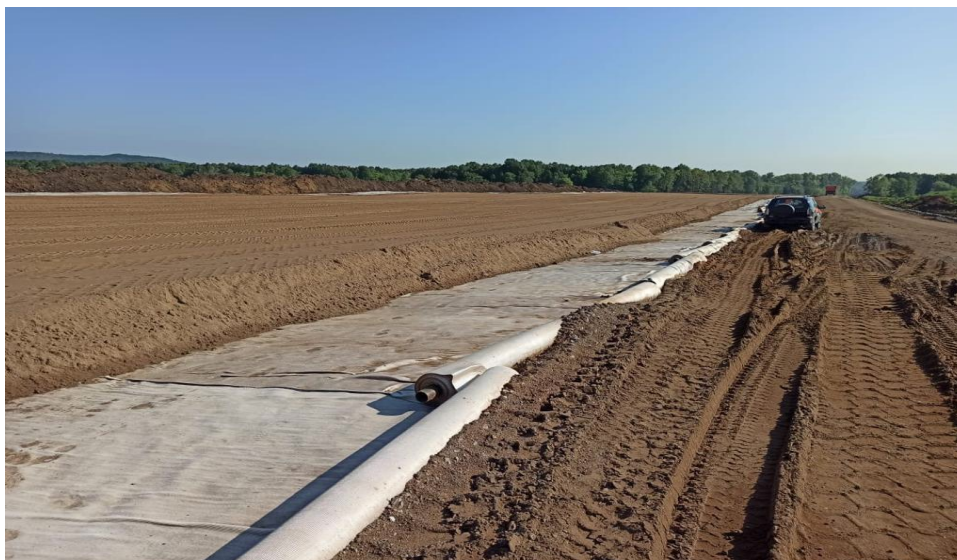
Рис. 3. Размещение геотекстиля на поверхности земляного полотна
