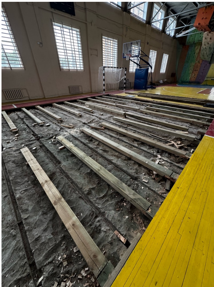
Проводится ремонт пола
