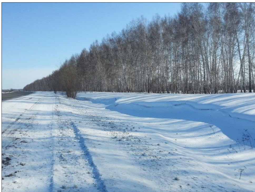
Рисунок 5.26 – Отложение снега в направлении автодороги у ажурной придорожной полосы (ПП 1)
