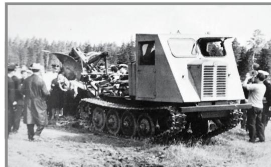
Тяжелый трактор С-100 с плугом-канавокопалелем (ПКНЛ-500) – мощная машина для проведения лесомелиоративных работ.
