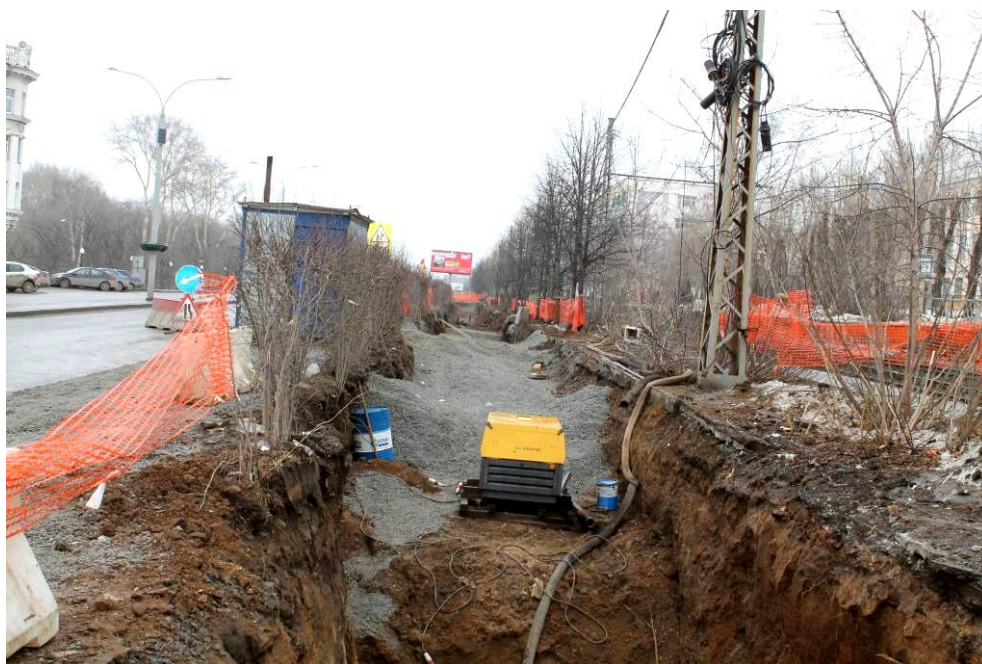
Рисунок М.2 – Реконструкция коммуникаций и дорожного покрытия на Верх-Исетском бульваре (осень 2015 г.– зима 2016 г.). Направление съемки – на юго-восток, в сторону ул. Московской (фото Кайзер Н.В.), 2016 г.
