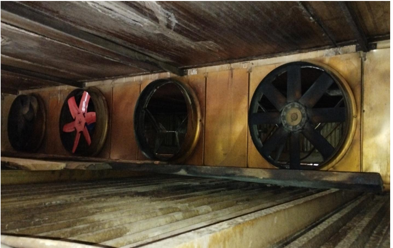
Рисунок 3.3 - Вентиляторные узлы камеры MGR-50
