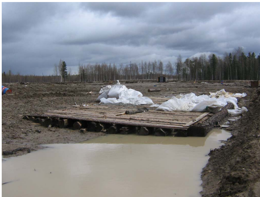
Рис. 4.13. Производственные отходы на не демонтированной после завершения бурения и испытания скважины площадке хранения реагентов.
