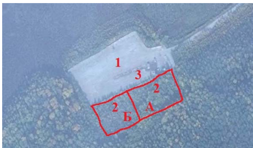
Рис. 5.5. Спутниковый снимок кустовой площадки № 29 по состоянию на 2015 г. (данные из общедоступного интернет-ресурса SAS.Планета), Тепловское месторождение:
