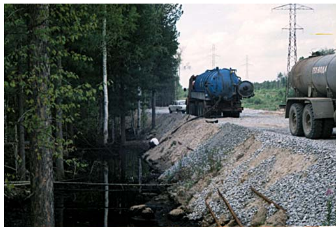
Рис. 5.30. Сбор пролитой нефти с пересекающих дамб на территории сильнозагрязненного товарной нефтью лесного участка в районе кустовой площадки № 122 Мамонтовского месторождения. Июль 1996 г.
