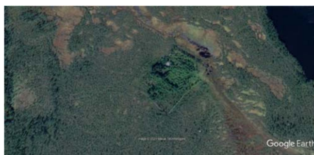
Рис. 4.17. Буровая площадка скважины Р-1 на спутниковом снимке 2017 г. (данные из общедоступного интернет-ресурса Google Earth) Нефтеюганский район, Тепловское месторождение
