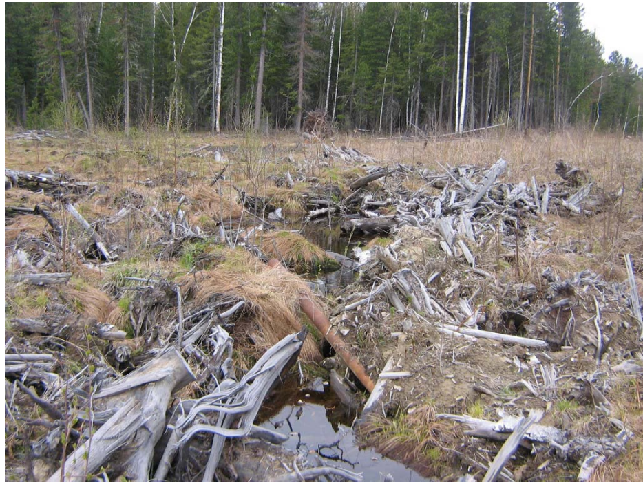
Рис. 4.15. Фрагмент площадки разведочной скважины с перекрытым поверхностным водотоком в результате его захламления порубочными остатками, выкорчеванными пнями, засыпки грунтом при строительстве площадки. Нижневартовский район, 2007 г.
