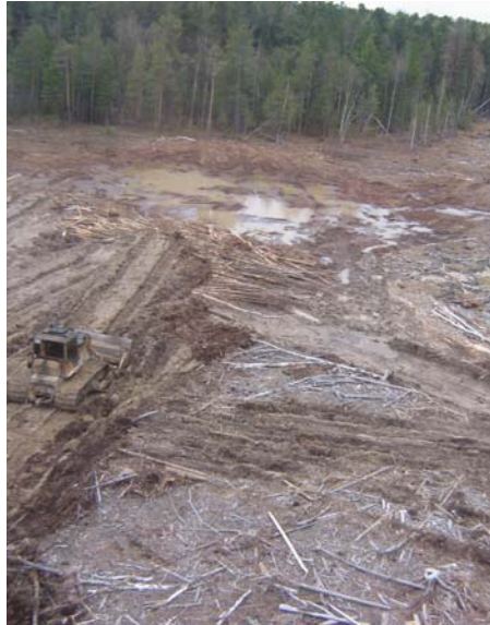
Рис. 4.7. Захоронение срубленной древесины бульдозером на территории буровой площадки
