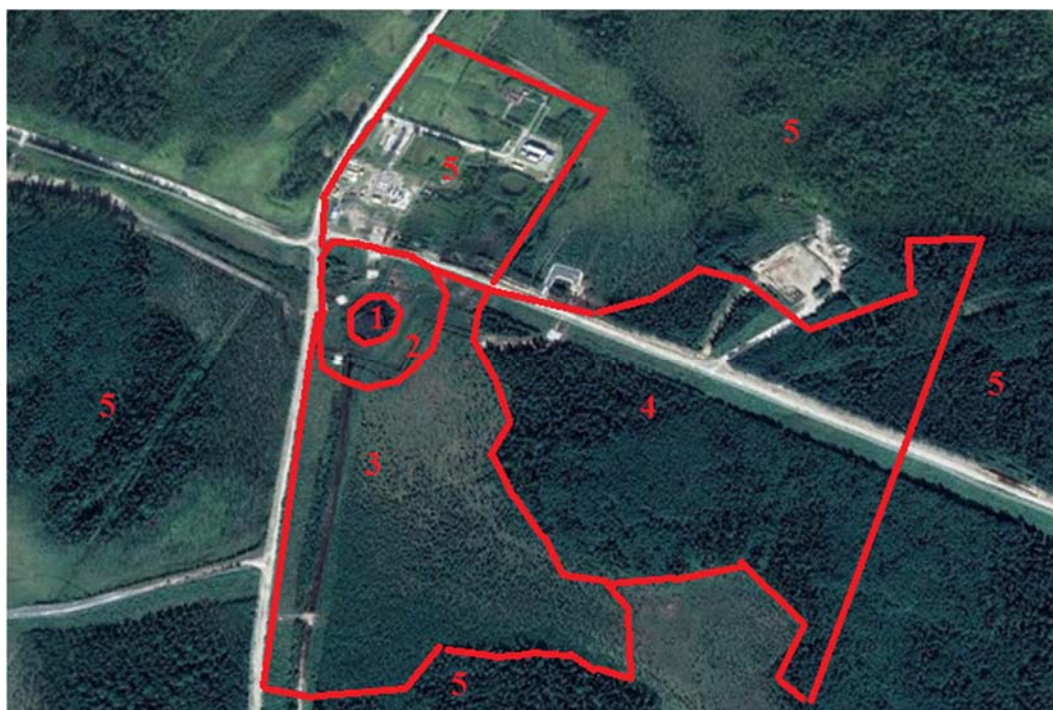
Рис. 5.52. Спутниковый снимок зон негативного воздействия факельной установки ДНС Кудринского месторождения (по данным общедоступного интернет-ресурса Google Earth). Нефтеюганский район, подзона средней тайги: 1 – зона факельного обвалования, 2 – охранная зона факела – 3 – зона погибших насаждений, 4 – зона ослабленных насаждений, 5 – зона условно фоновых насаждений, 6 – территория производственной площадки ДНС Кудринского месторождения
