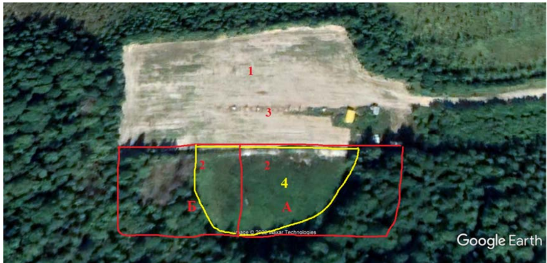
Рис. 5.9. Спутниковый снимок кустовой площадки № 29 по состоянию на 2020 г. после рекультивации вспомогательной зоны посевом трав (данные из общедоступного интернет-ресурса SAS.Планета). Нефтеюганский район, Тепловское месторождение:
