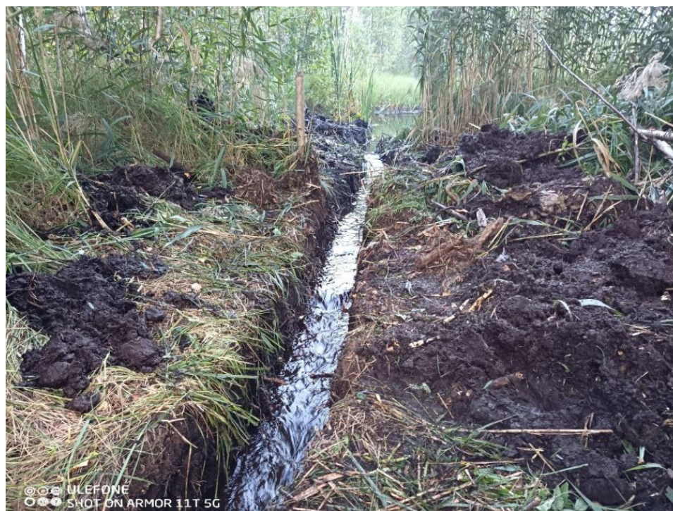
Рис. 4.21. Один из каналов, соединяющий карьеры гидроторфа с ниже расположенными горящими фрезерными картами
