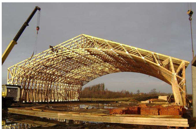
Рисунок 1.4 – Монтаж крупногабаритной ферменной конструкции из древесины
