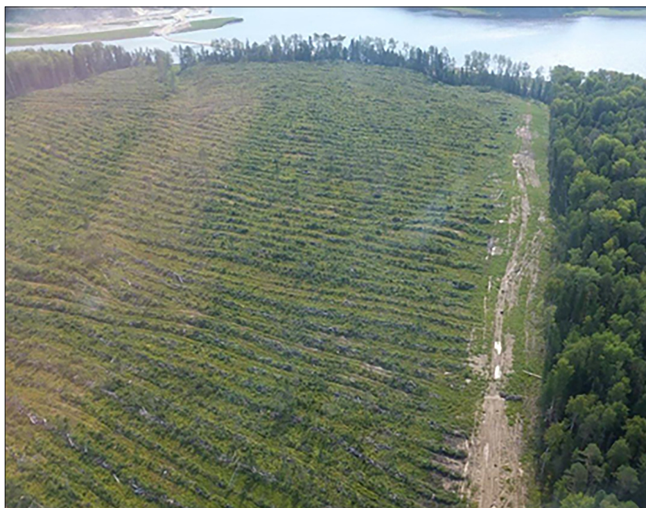
Рис. 1. Участок с вырубленной древесно-кустарниковой растительностью, предназначенный для строительства объекта
